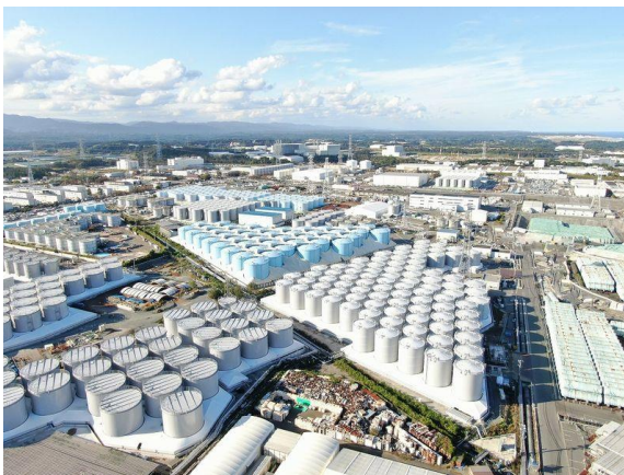
<写真1> 福島第1原発の敷地内にある処理水のタンク
